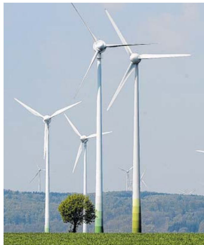
Windräder: Auch in der Nähe von Wever könnten sich künftig die Windkraftanlagen drehen. FOTO: MARC KÖPPELMANN
